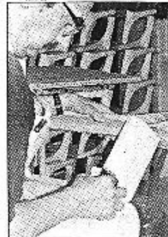
Alle Unebenheiten werden vor dem Schleifen zugepachtelt
